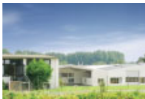
AKG Thermotechnik GmbH & Co. KG Hofgeismar, Germany
